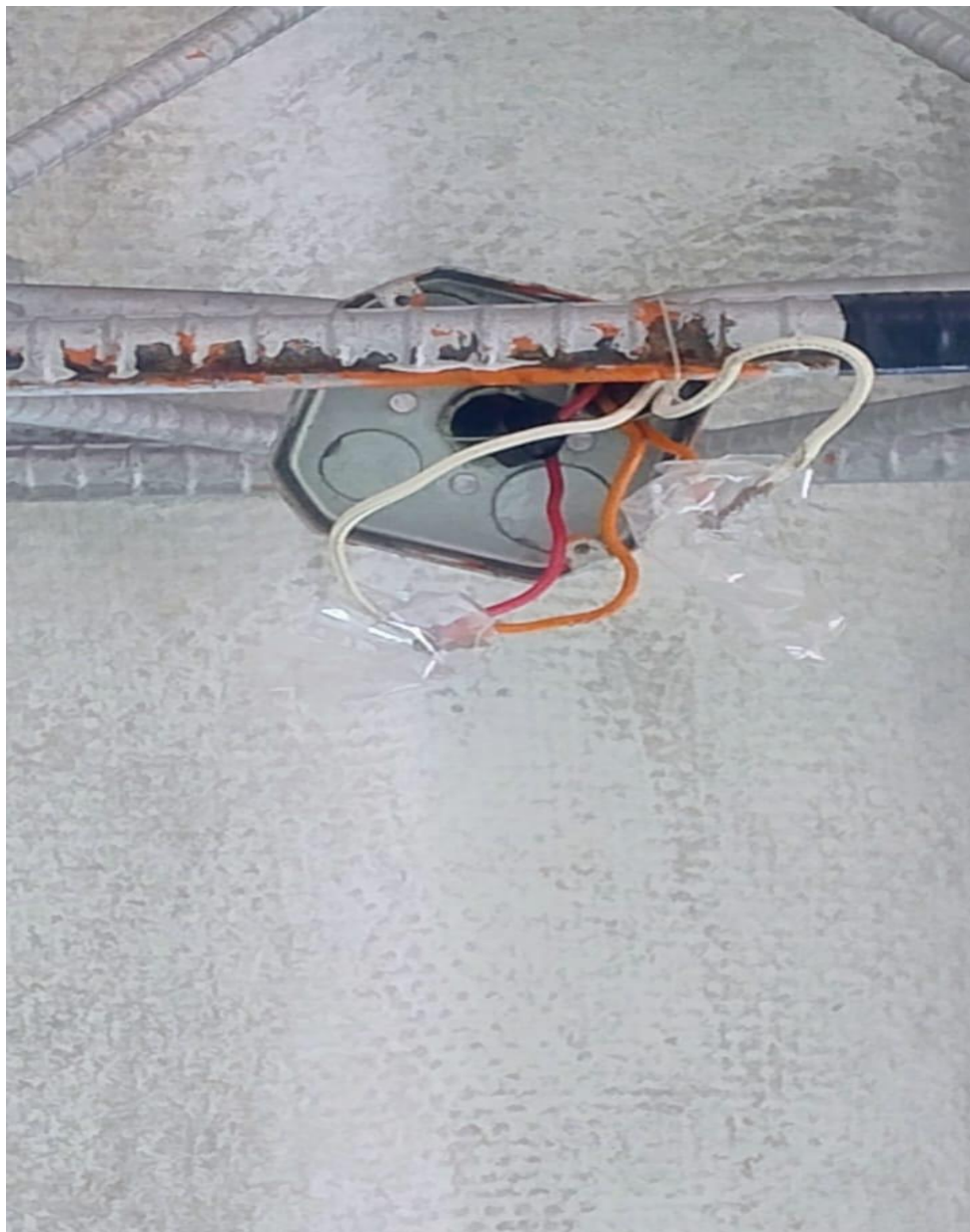
Figura 3 Caja de derivación s de los salones
