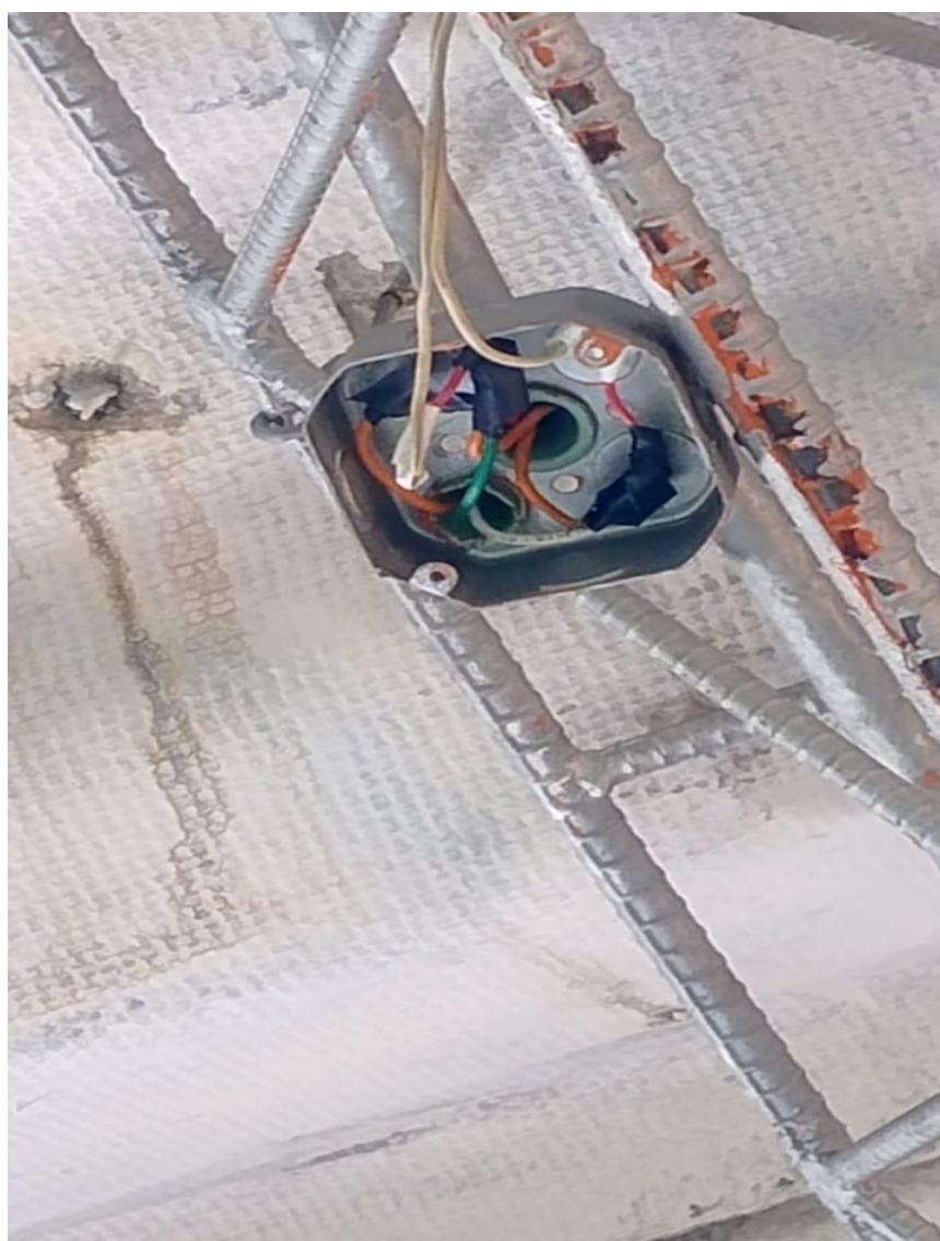
Figura 4 Caja de derivación de los salones
